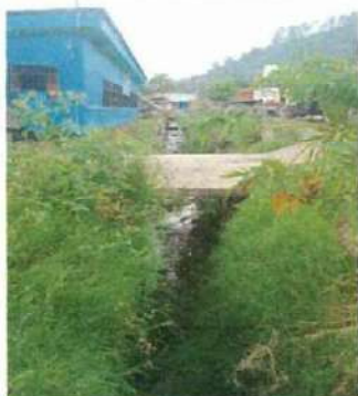
Foto 15: Mejoramiento de cuneta de paso y recolectora de aguas pluviales, debido al riesgo de caminamiento y malos olores.
