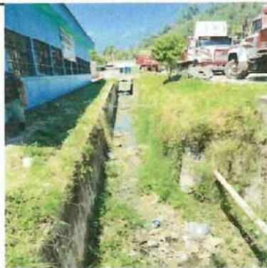
Foto 14: Mejoramiento de cuneta de paso y recolectora de aguas pluviales, debido al riesgo de caminamiento y malos olores.
