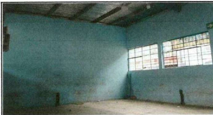
Foto 10: Aplicación de pintura acrílica y de esmalte en interior de paredes aulas, dirección y baños.
