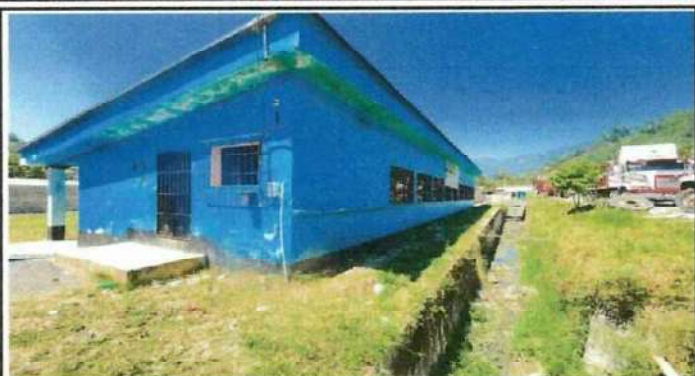
Foto 13: Aplicación de pintura acrílica y de esmalte para exterior de paredes, en todo el establecimiento público.
