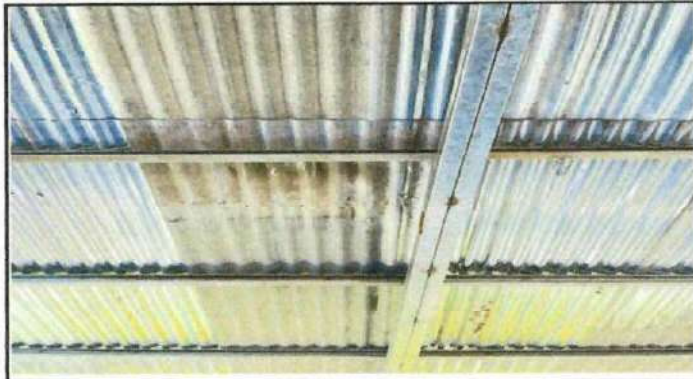
Foto 2: Cambio de cubierta de lamina acanalada en mal estado (filtraciones de agua) por lamina troquelada para mayor durabilidad de la misma en aulas, dirección y baños.
