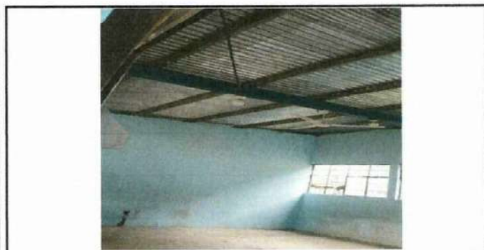
Foto 5: Mantenimiento de estructura metalica (lijado y limpiado) y pintado de la misma, en aulas, dirección y baño.
