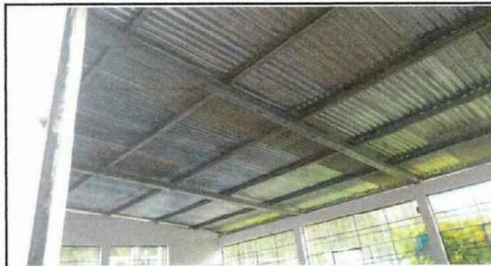
Foto 4: Mantenimiento de estructura metalica (lijado y limpiado) y pintado de la misma, en aulas, dirección y baño.
