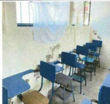
Foto 8: Mejoramiento de infraestructura, resanado de paredes en areas especificas (relleno y repello nuevo).
