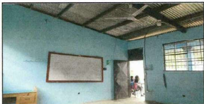
Foto 11: Aplicación de pintura acrílica y de esmalte en interior de paredes aulas, dirección y baños. Asi mismo mantenimiento de puertas (lijado y pintado) por su mal estado.
