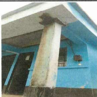
Foto 9: Mejoramiento de infraestructura, resanado de paredes en areas especificas (relleno y repello nuevo).
