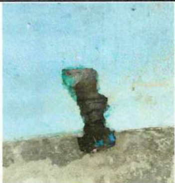
Foto 7: Mejoramiento de infraestructura, resanado de paredes en areas especificas (relleno y repello nuevo).
