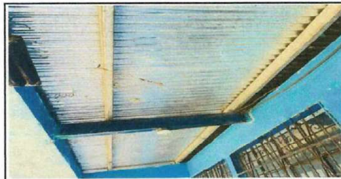
Foto 6: Mantenimiento de estructura metalica debido a la corrosión (estructura principal).
