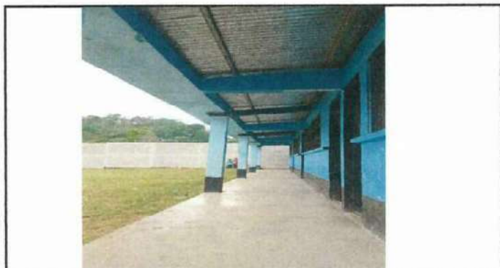
Foto 3: Sustitución de lamina acanalada en mal estado (oxidación y filtraciones de agua) por lamina troquelada en area de corredor establecimiento educativo.
